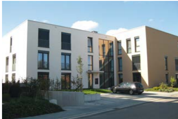
2013: Seilerstraße 8 und 10 in Bad Boll, 10- und 11-Familienwohnhauses, Effizienzhaus 55
