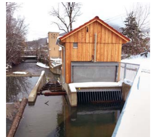
Neubau WKA Deggingen mit Fischaufstieg
