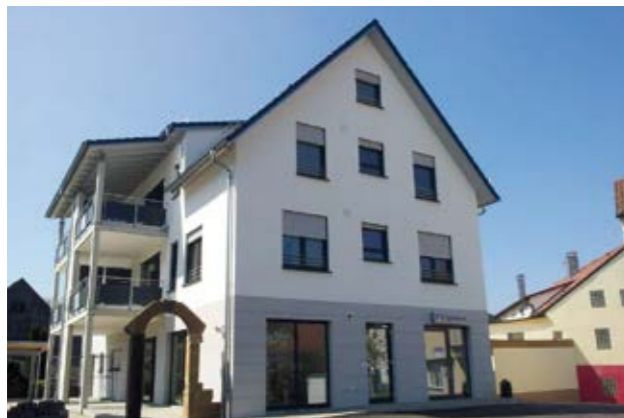
2014: Gmünder Straße 21 in Donzdorf-Winzigen, Wohn- und Geschäftshaus mit vier Wohnungen und zwei Gewerbeeinheiten, Effizienzhaus 55
