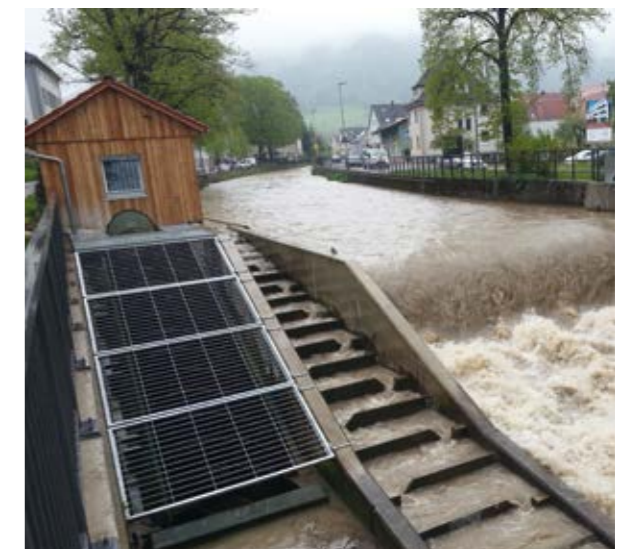
Neubau WKA Deggingen mit Fischaufstieg
